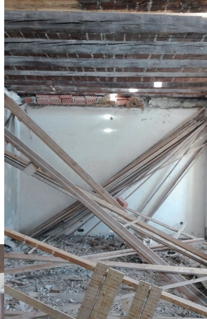
Die Trambalken im Zimmer „Gotik“, bevor sie abgeschliffen und gereinigt wurden
