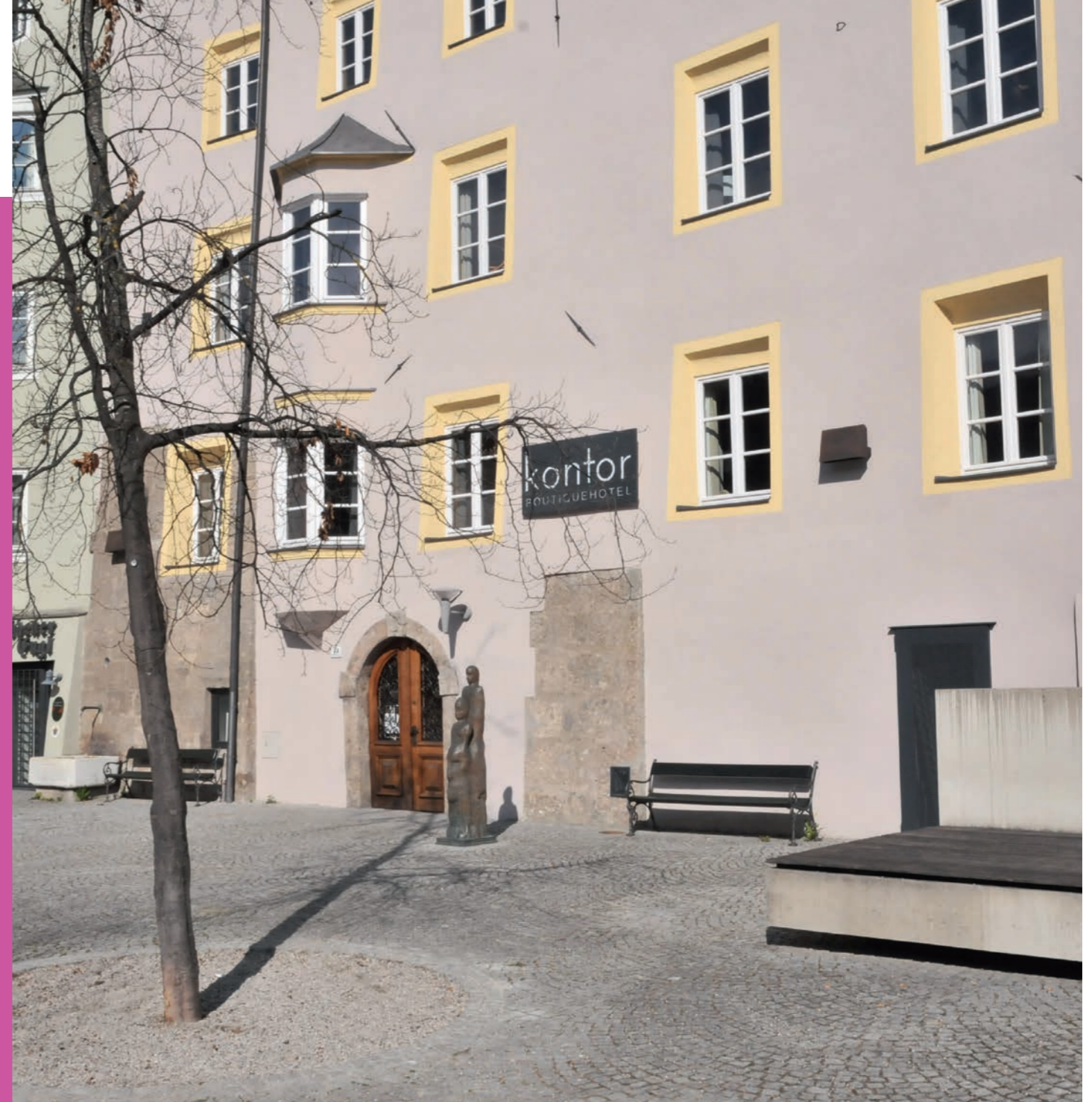
Außenansicht Hotel Kontor am Unteren Stadtplatz. In der Vergangenheit drehte sich in Hall alles rund um die Entstehung der Münzen sowie die Gewinnung von Salz. Bis heute sind diese Spuren der Zeit in den Häusern zu entdecken.
